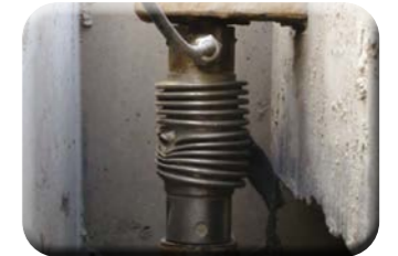
Fysiske skader Indeslutningen er udstyret med et system, der registrerer og advarer om brud.
